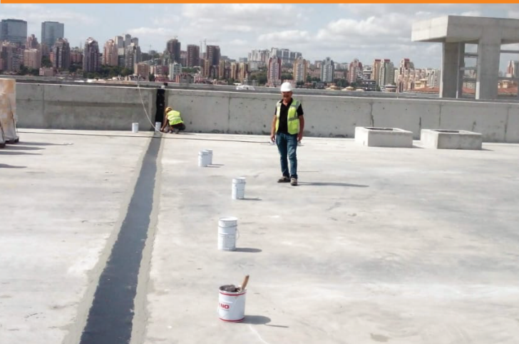
Akyapı Sudursun Dilatasyon bandı ve Epoksi yapıştırıcı
