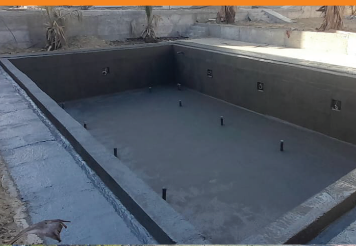
Berken Yapı Celaliye Villa Havuz Yalıtımı /Çimento Esaslı Sürme Su Yalıtım
